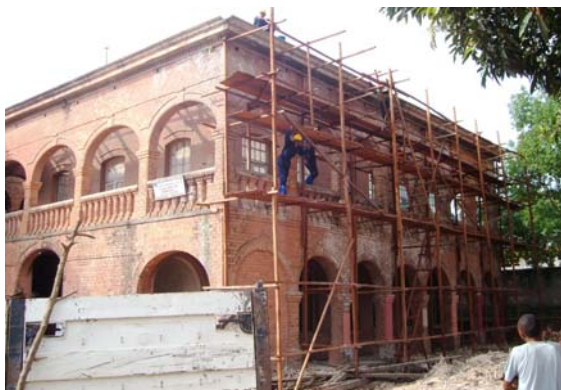
Le Ministère de l'Intérieur en pleine réhabilitation.
