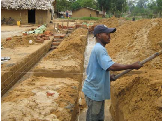
Le chantier de l'école primaire Mangada à Bafwasende.
